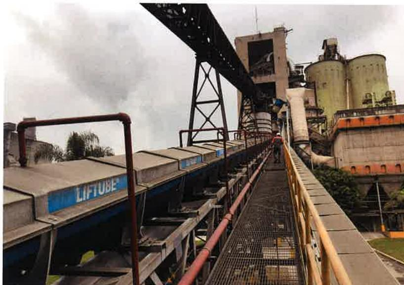
Cinta transportadora de residuos para la alimentación del horno.
