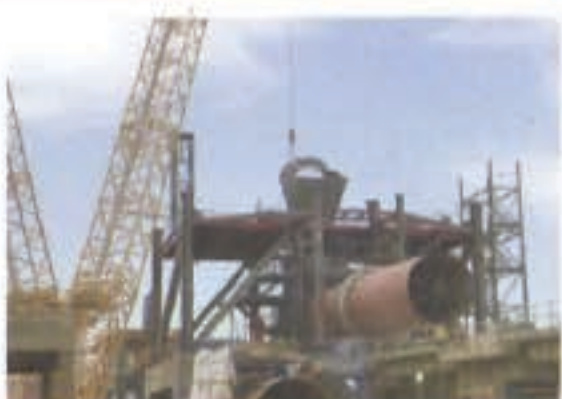
CIMENTS DE L'ATLAS, Maroc, Beni Mellal: Le montage de la ligne de 3.600 t/j est en cours.
