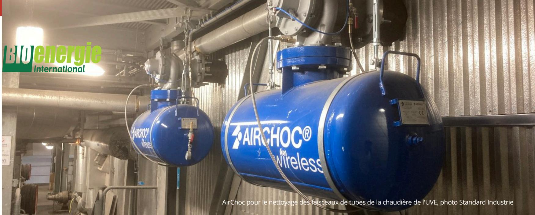
AirChoc pour le nettoyage des faisceaux de tubes de la chaudière de l'UVE, photo Standard Industrie
