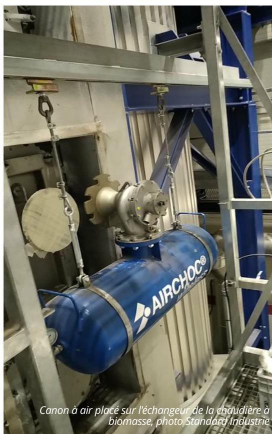
Canon à air placé sur l'échangeur de la chaudière à biomasse, photo Standard Industrie
